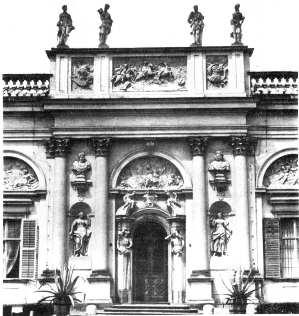
14. Pałac w Wilanowie. Fragment elewacji frontowej skrzydła północnego z rekonstruowanymi posągami. Fot. T. Szymańska.
