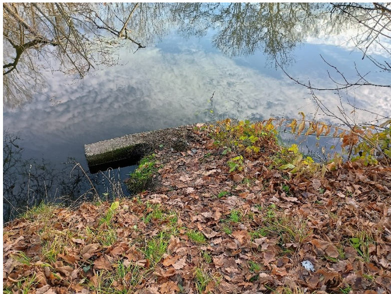
Fot. 2 Mnich północny – widok od strony Jeziora Wilanowskiego
