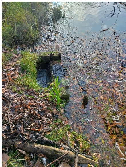
Fot. 1 Mniczek północny – widok od strony Stawu Południowego
