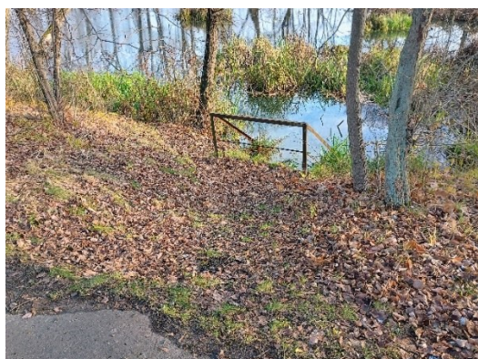
Fot. 4 Lokalizacja mnicha na środku grobli – widok od strony Jeziora Wilanowskiego – widoczne zagłębienie terenu wzdłuż przebiegu rurociągu od mnicha.
