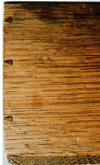
Miniaturowe wczepy, łączące naroża dębowych szufladek, wykonane są z zadziwiającą precyzją.
